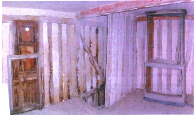
6 L'oriol, véritable chambre de guet couronnant l'escalier
