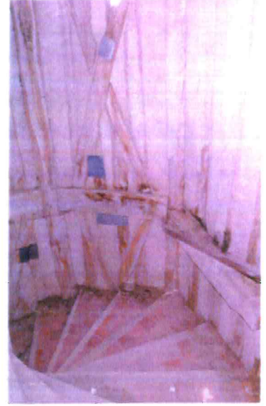
1 à 4 L'escalier en vis de la tourelle d'escalier à 5 pans: d'abord en pierre, noyau et marches suivent le changement de matériaux observé en façade en se transformant en bois, avec recouvrement en tomettes.
