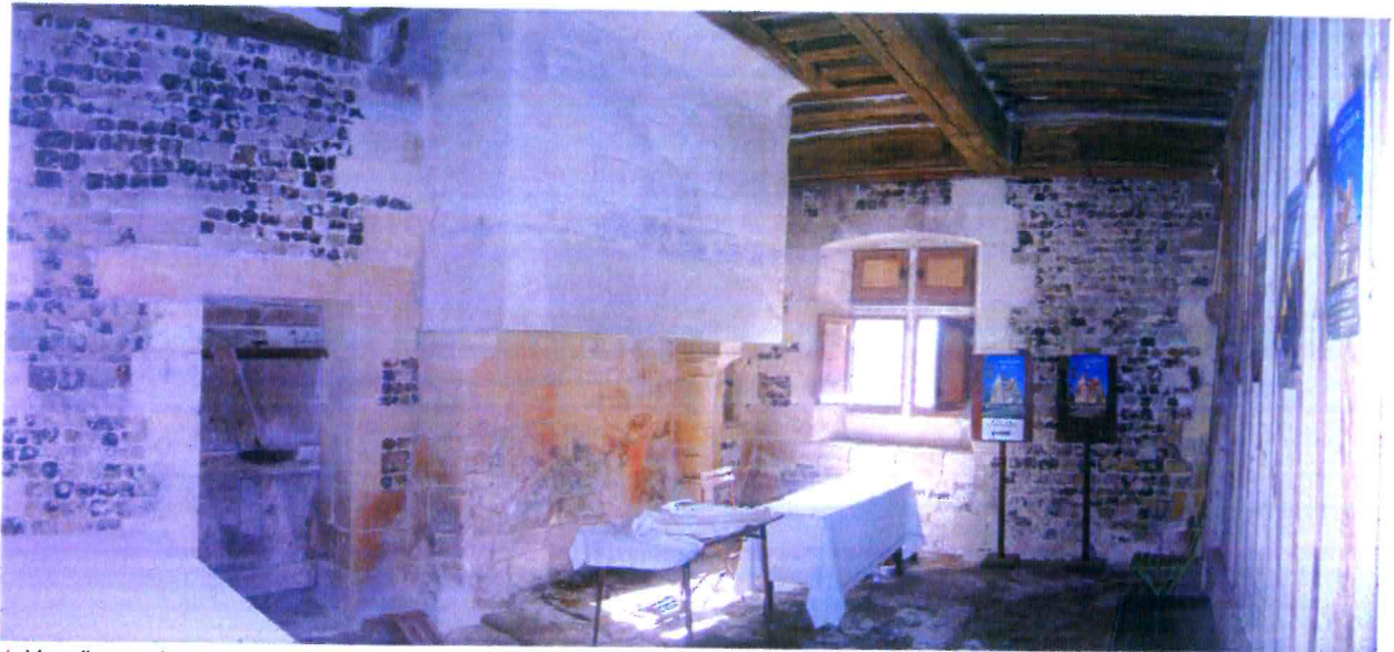
1. Vue d'ensemble sur la 1ère pièce avec son imposante cheminée à piédroits à colonnettes
