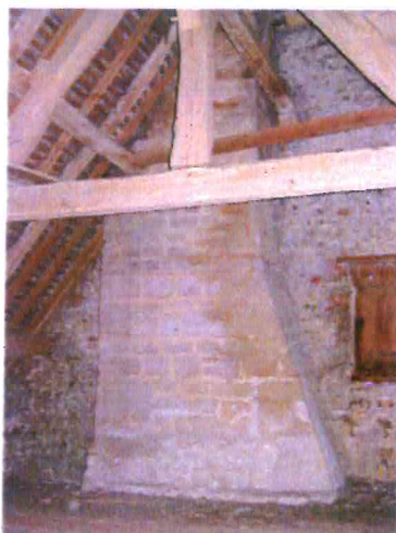
5 Conduits de cheminées accolés aux 2 pignons.
