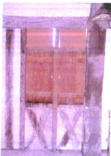
3 Croisée en bois disposant d'allèges contreventées en croix de St-André
