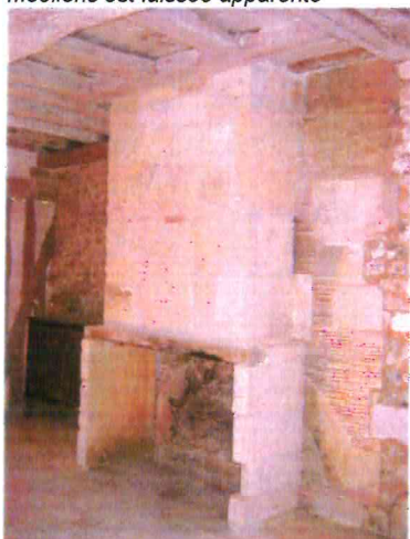
2. Cheminée devenue simple foyer. On distingue l'ancienâtre en tuileaux horizontaux ainsi que le cintre de l'arc de décharge dépassant
