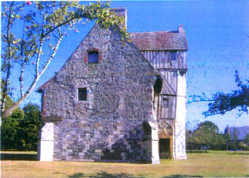
1. Vue sur le pignon Sud
