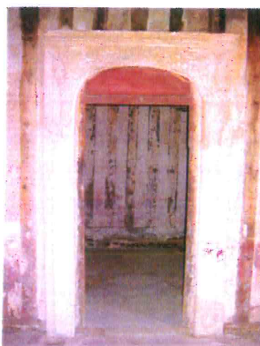
3 et 4 Ouverture avec chambranle dessinant un linteau à arc surbaissé. On distingue sur le rebord supérieur la base d'une colonnette.
