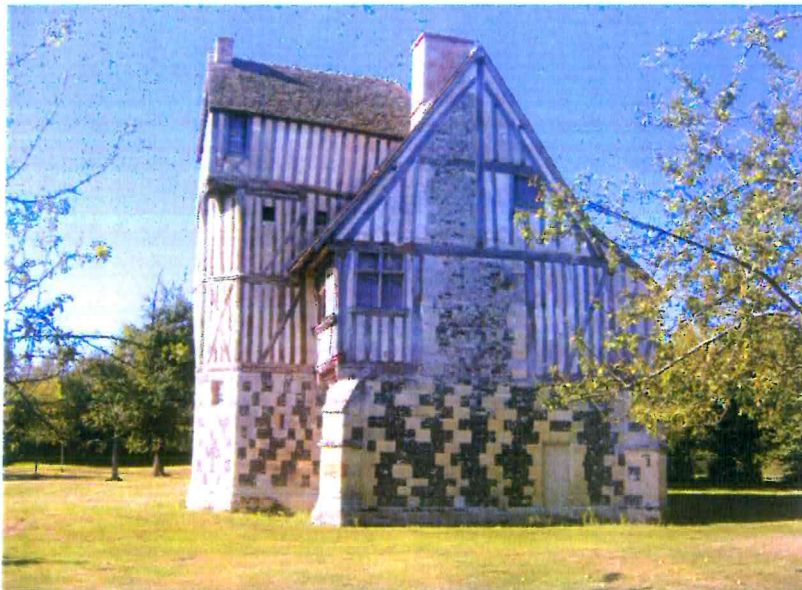
1. Vue sur le pignon Nord
