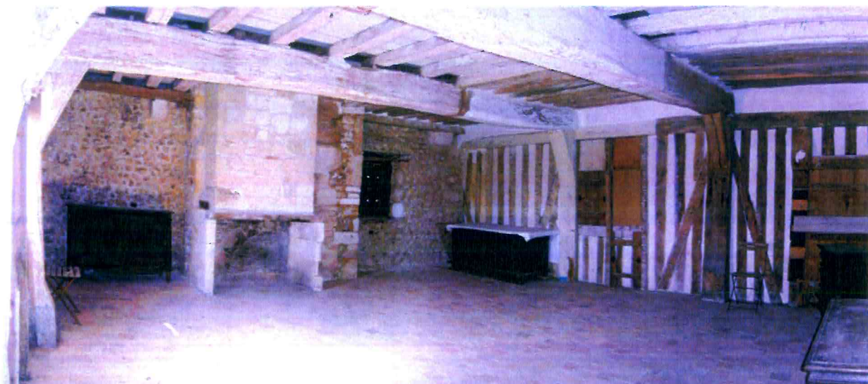
1. Vue d'ensemble sur la première chambre. L'ancien cloisonnement se lit sur les poutres maitresses. La constitution du pignon Sud en moellons est laissée apparente
