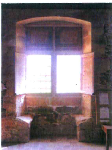
2. Coussiège positionné dans l'ébrasement de la baie
