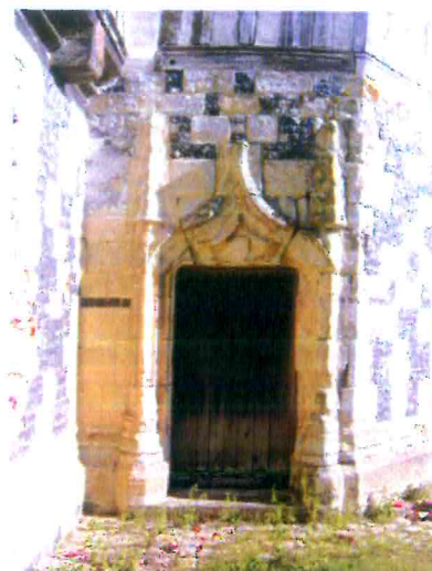
2. Porte ornée d'une archivolte en accolade
