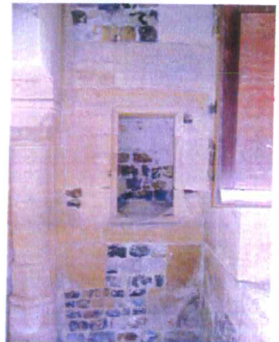
4. Niche pratiquée dans le pignon Nord
