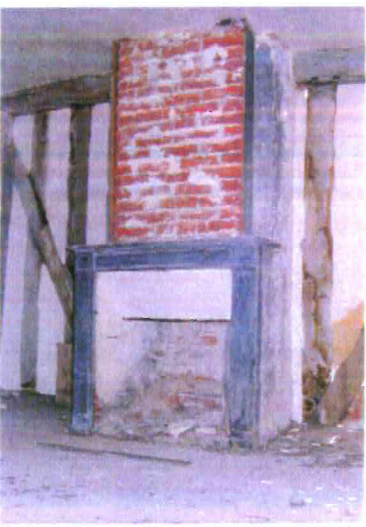
7 Cheminée dont le conduit se lit sur la façade Est
