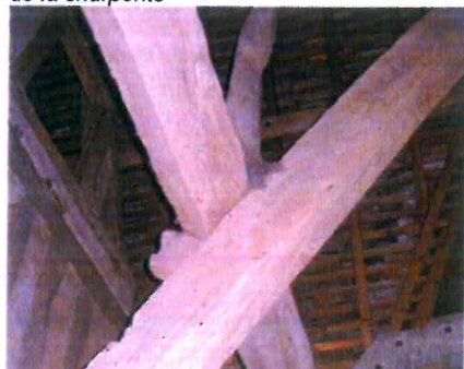
4. Jonction arbalétrier / panne et sa chantignolle / potelet supportant le faîtage de l'oriol.
