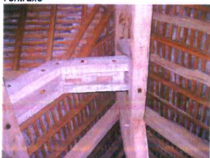
3 Renfort de réemploi venant limiter le dévers de la charpente
