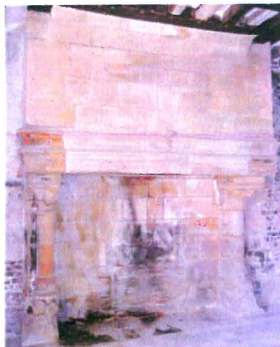
3. Cheminée à colonnettes : bases et chapiteaux portant un linteau en pierre mouluré
