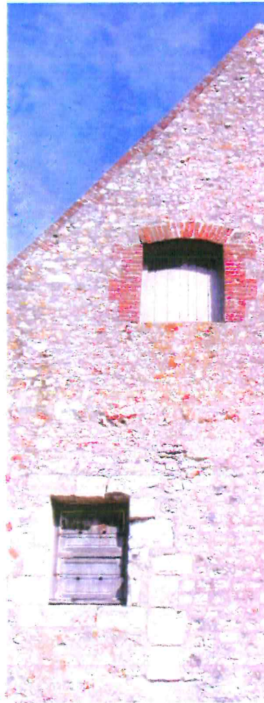
2. Percements non alignés du pignon Alternance encadrement pierre / brique
