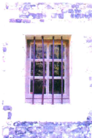
4, 5, 6. Vues sur ouvertures du Rez-de-chaussée: Porte d'entrée, fenêtre avec grille en fer et croisée à montant et traverse de pierre
