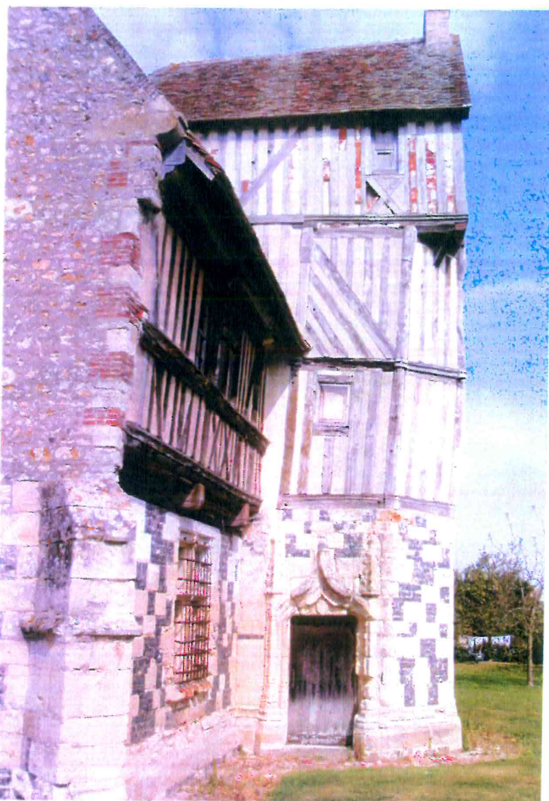
1. Vue de profil de la tour d'escalier hors-oeuvre et de son oriol.
