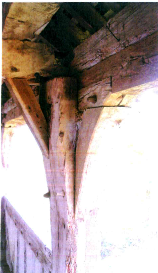
2. Potelets à triple aisselier recevant la couverture de la galerie. Exemple d'assemblages à mi-bois et à tenon et mortaise fixés par des chevilles
