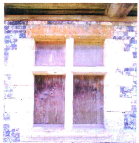
4, 5, 6. Vues sur ouvertures du Rez-de-chaussée: Porte d'entrée, fenêtre avec grille en fer et croisée à montant et traverse de pierre
