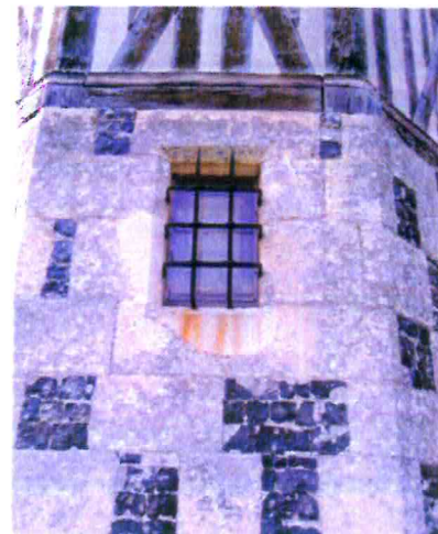
4. Détail sur une des fenêtres de la tour
