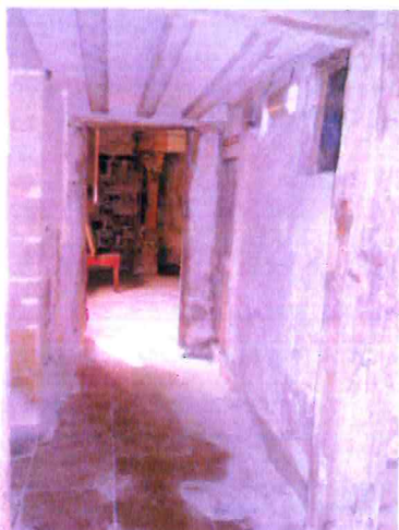
2. Passage assurant la jonction entre les deux salles du RdC et l'escalier
