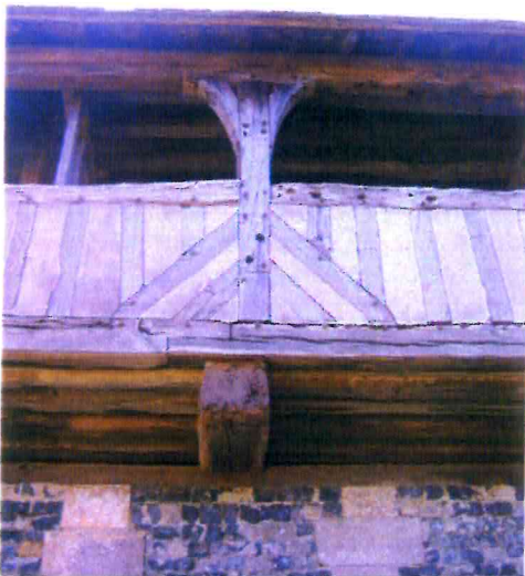
2 et 3. Les potelets verticaux sont soutenus par des sommiers dont les têtes sont laissées apparentes
