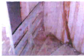
1 à 4 L'escalier en vis de la tourelle d'escalier à 5 pans: d'abord en pierre, noyau et marches suivent le changement de matériaux observé en façade en se transformant en bois, avec recouvrement en tomettes.
