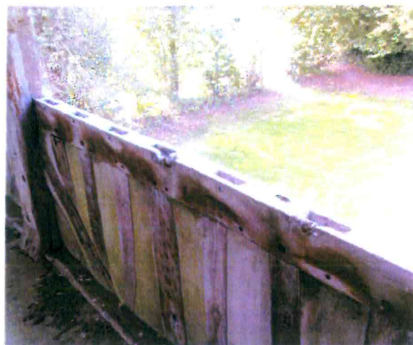
3. De nombreux bois sont des pièces de réemploi portant les stigmates d'assemblages
