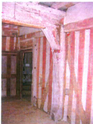
3. Poteau à aisselier courbe portant une poutre. On aperçoit les renforts métalliques
