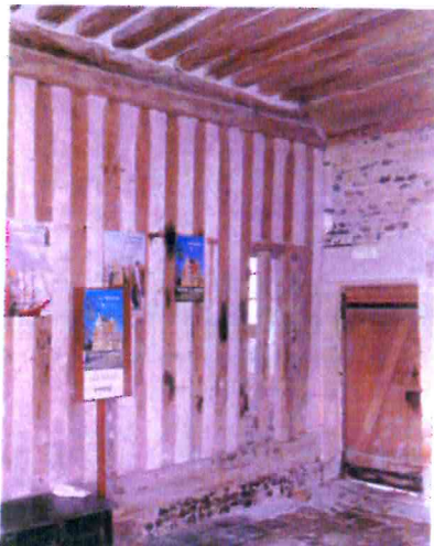
2. Cloison de séparation à pans de bois surhaussée par un soubassement de silex .
