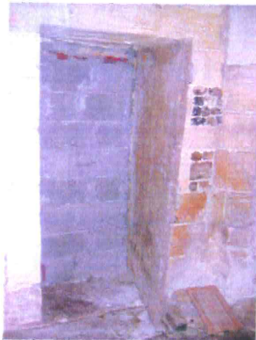
3. Ouverture murée. La porte a été conservée à l'extérieur
