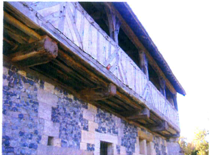
2 et 3. Les potelets verticaux sont soutenus par des sommiers dont les têtes sont laissées apparentes
