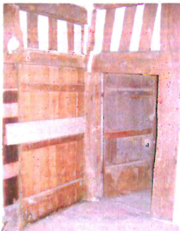
5. Portes d'accès à la seconde chambre et à la galerie. Cette dernière est condamnée
