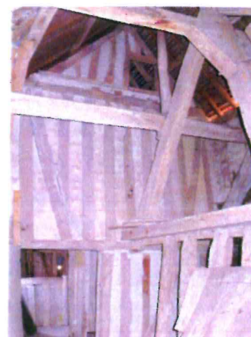
6. L'oriol vient reposer sur le corps principal du Manoir
