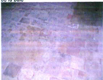
5. Revêtement du sol en carreaux de terre cuite.
