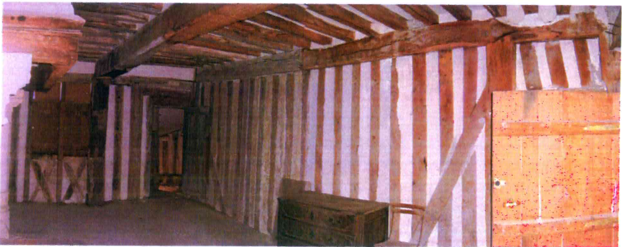
1 et 2. Vue d'ensemble sur la plus petite chambre avec la cheminée trônant au centre. Le colombage forme un véritable décor.
